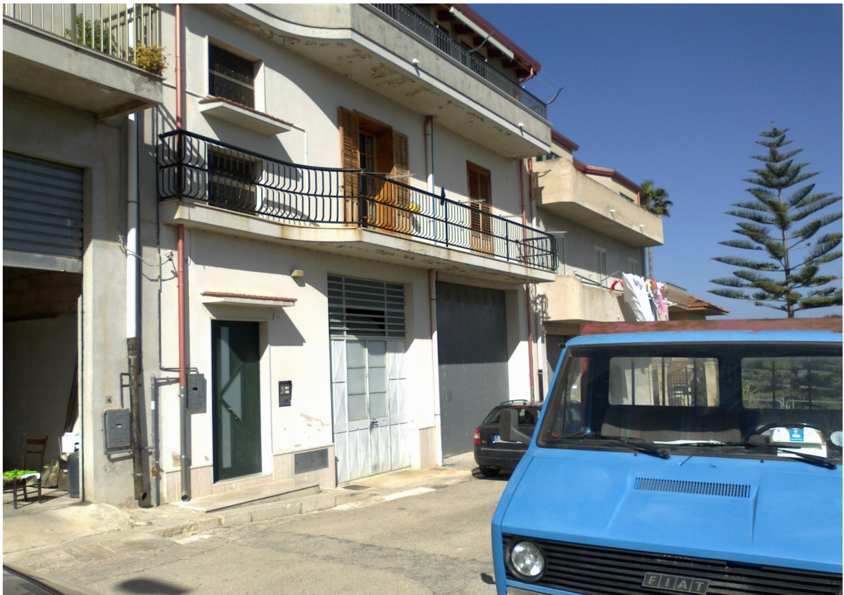
FOTO N.6 VISTA ESTERNA PROSPETTO
